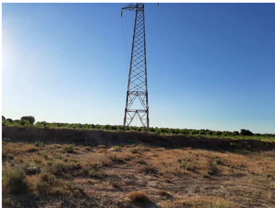
Foto 2. Tendido eléctrico existente junto al hueco existente.
