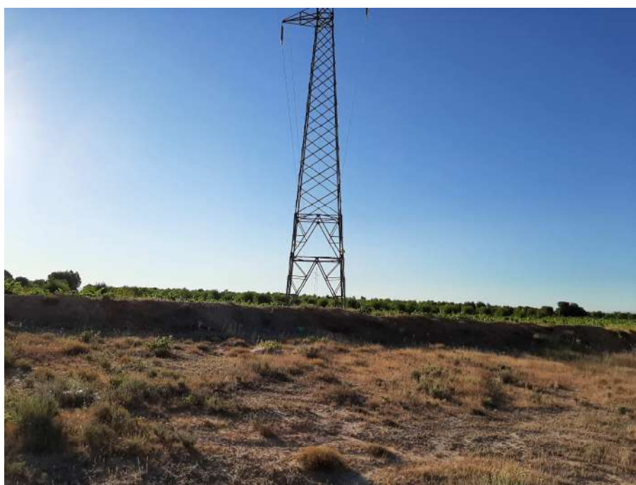
Foto 2. Tendido eléctrico existente junto al hueco existente.
