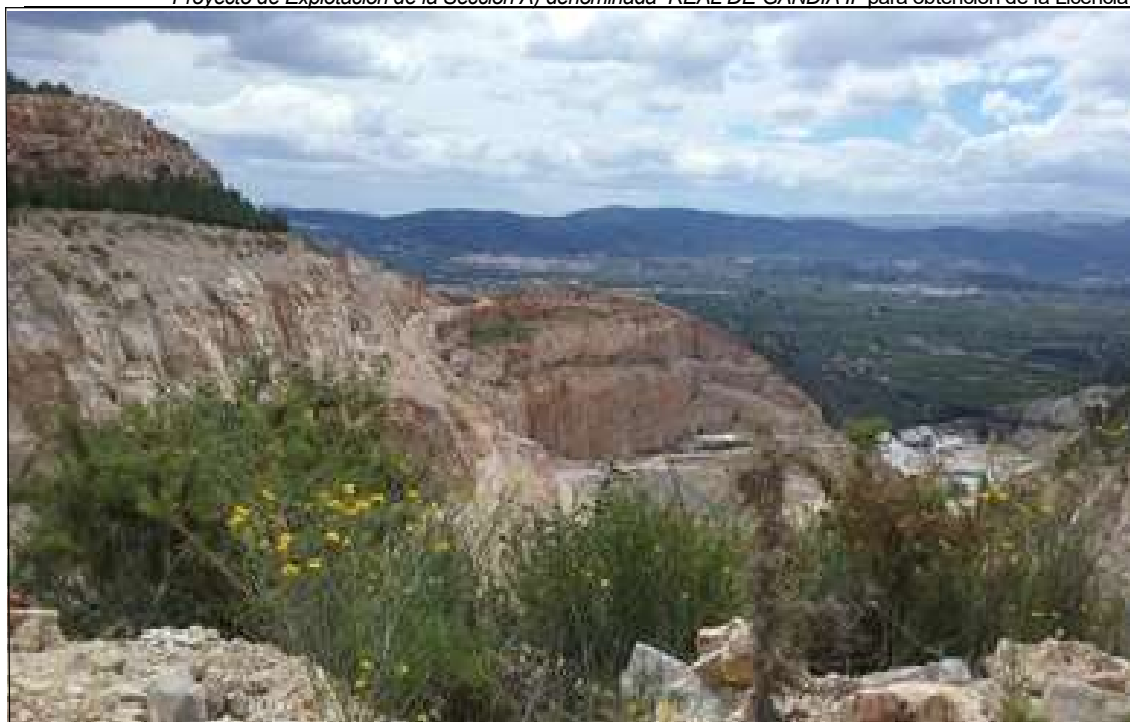
Frente Este ya explotado. Aportación de tierras en bermas superiores.
