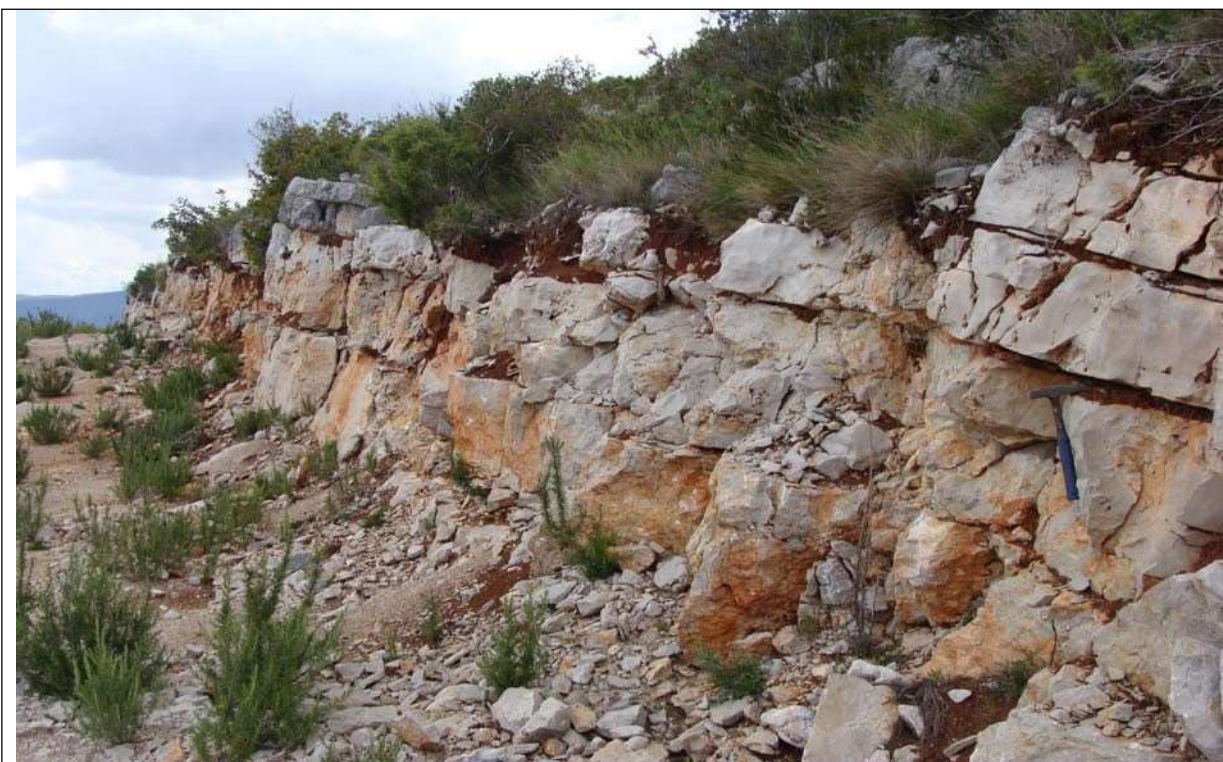
Fotografía n° 5.- Detalle de un talud donde se aprecian la potencia de los estratos calcáreos en la parte superior de la zona de explotación.
