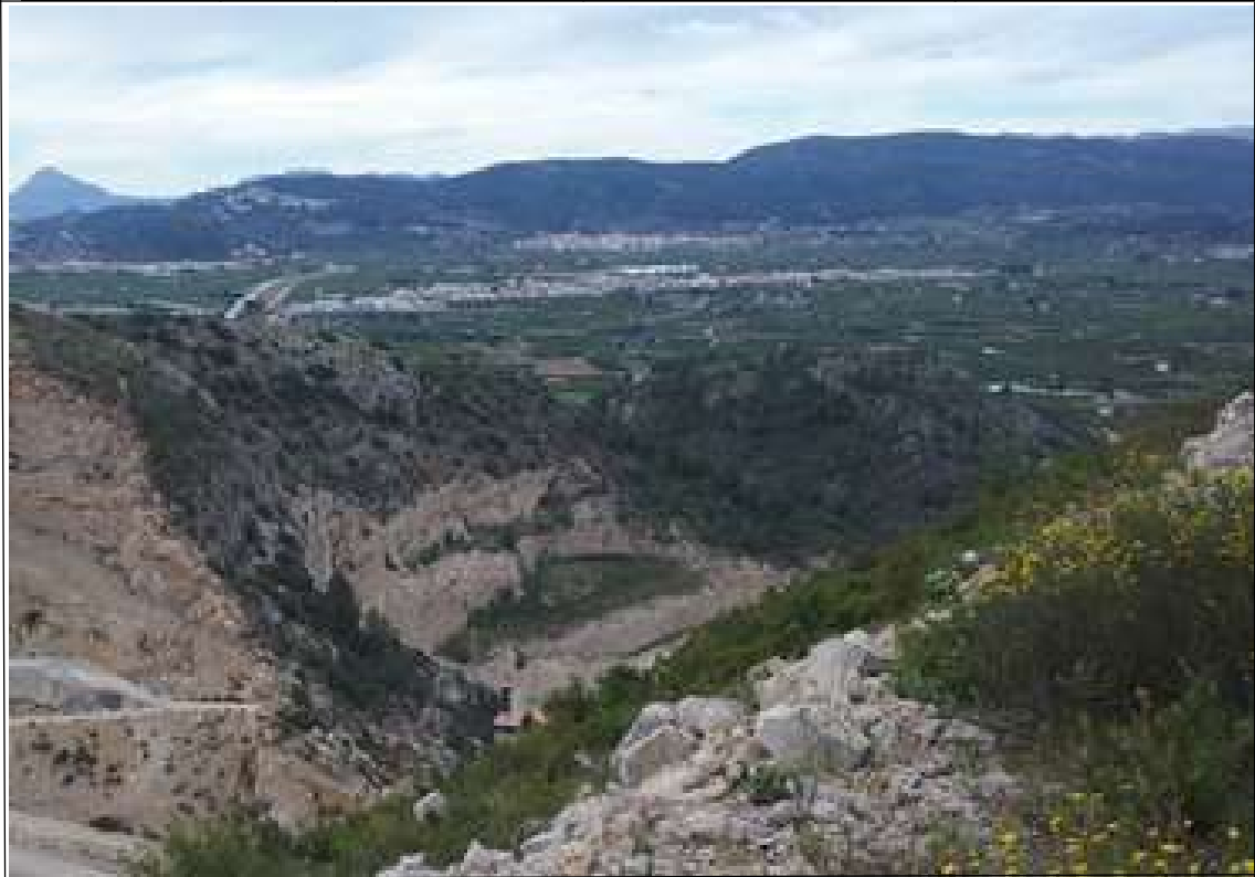
Talud Este de la plaza de las instalaciones
