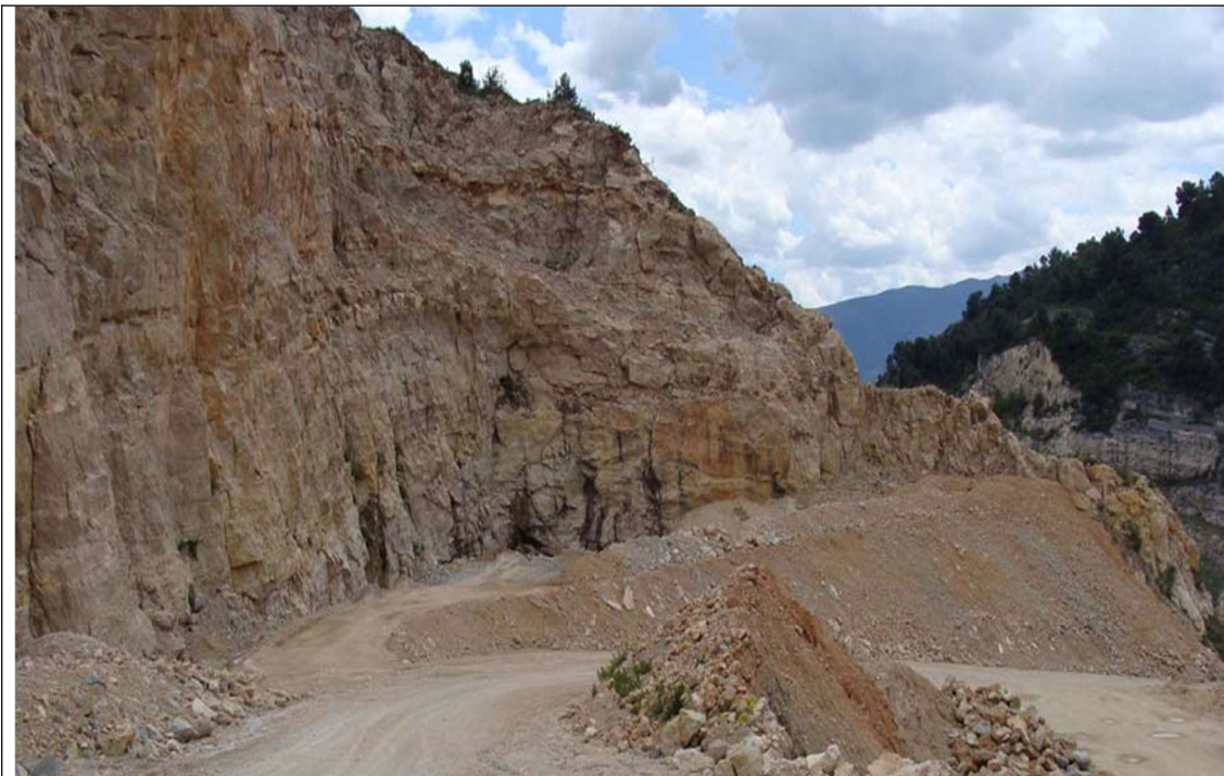
Inicio de las labores de restauración mediante relleno, que se están realizando en el talud del Este de la cantera, frente a la zona de explotación, con el fin de eliminar el talud vertical de la izquierda de la imagen.
