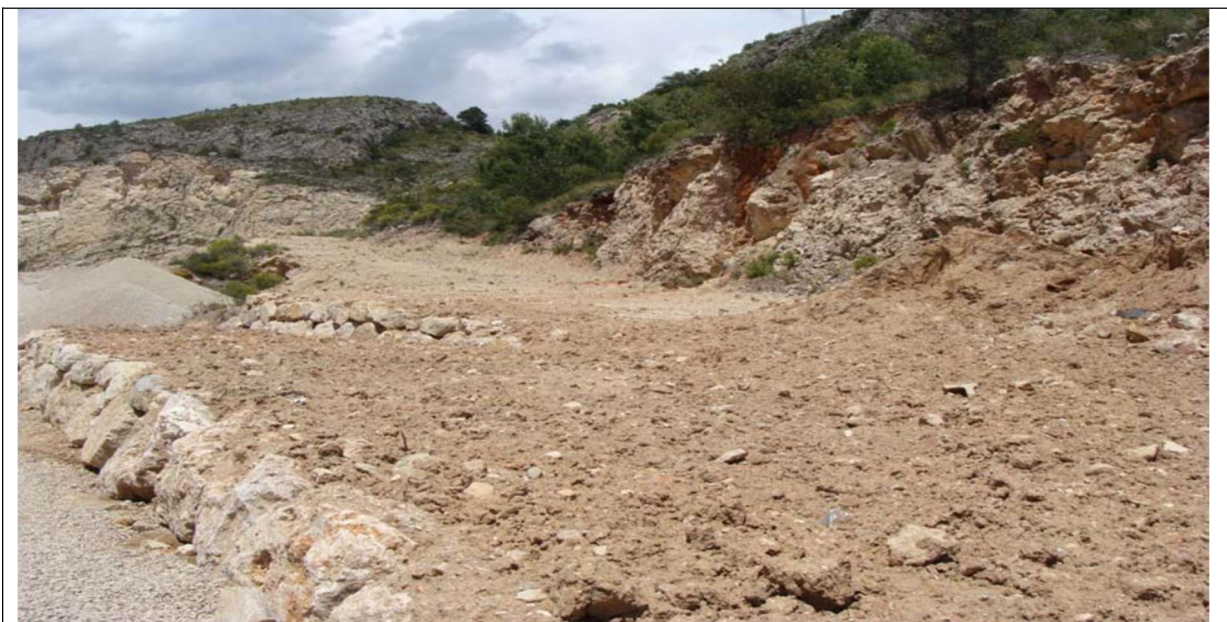
Zona restaurada a la entrada de la cantera, a la derecha donde en breve se procederá a la revegetación.
