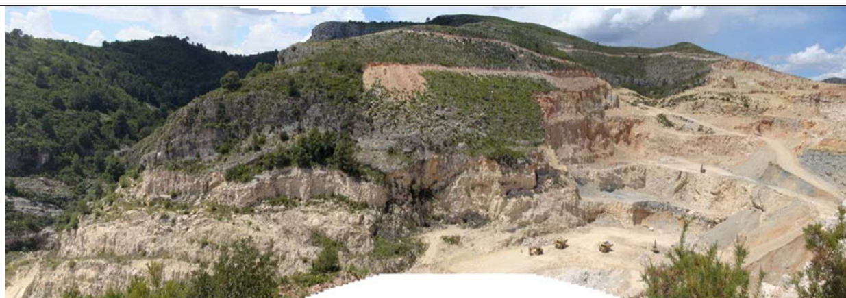
Fotografía n° 2.- Panorámica de la zona de explotación-restauración, tanto en la plaza da cantera (abajo a la derecha de la imagen) como de la ladera (centro imagen).
