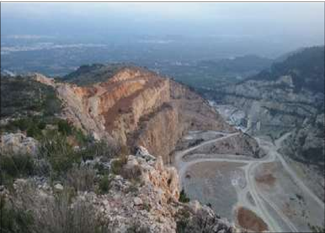
Frente Este ya explotado. Aportación de tierras en bermas superiores.
