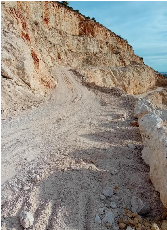
Ilustración 1: Trabajos de mejora en las bermas
