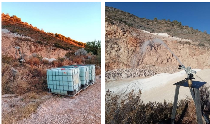
Ilustración 2: Riego de acopios
