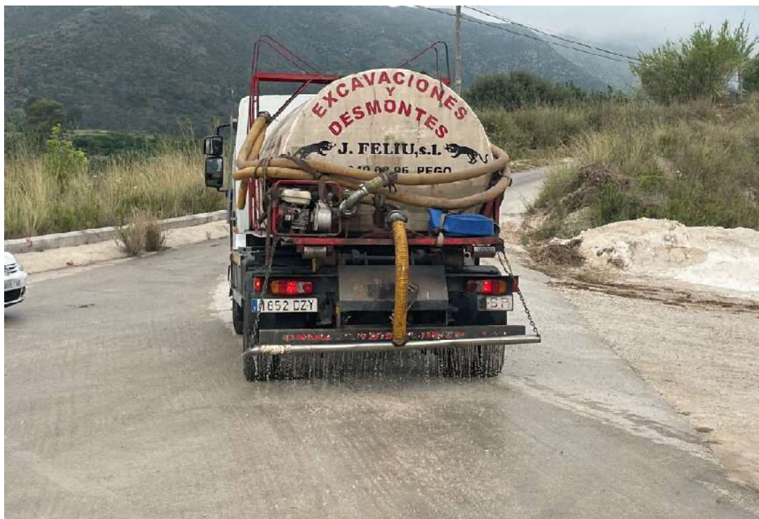
Ilustración 1: Riego de pistas y zonas de circulación mediante un camión cisterna.
