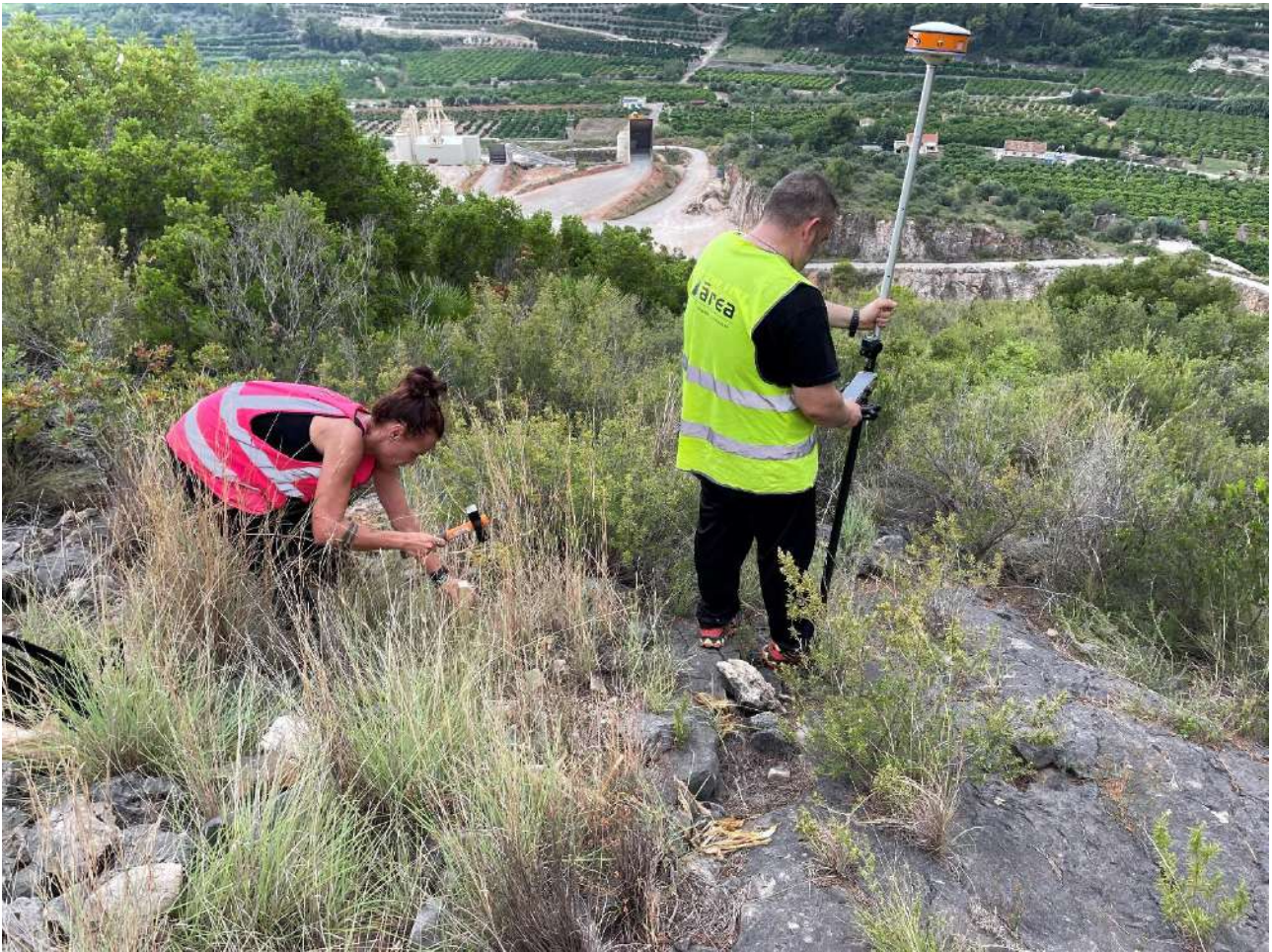
Ilustración 1: Trabajo de campo: replanteo de los vértices R-9 y V-9 en el monte con los topógrafos de Area Topografía.
