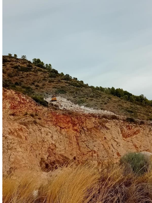
Ilustración 2: Trabajos de acondicionamiento
