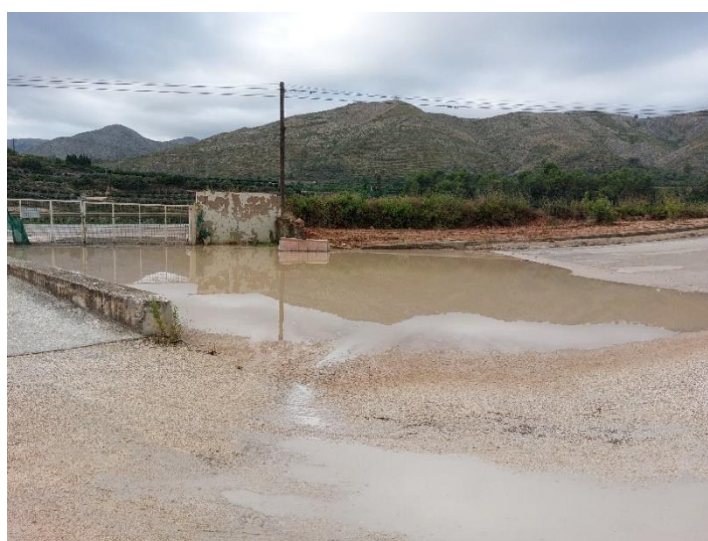
Ilustración 1: Acumulación agua de escorrentía tras fuertes lluvias
