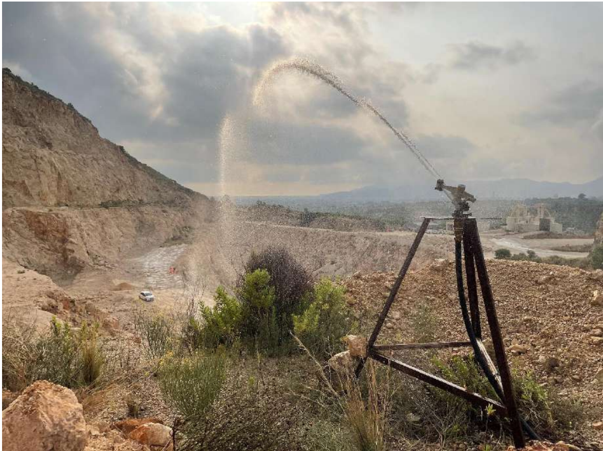
Ilustración 2: Ubicación del cañón de agua, con respecto a la voladura 100
