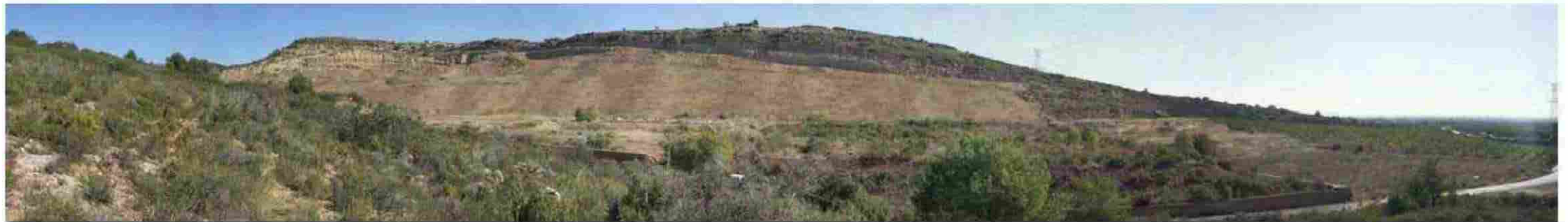
FASE III. Se continúa con el relleno para conseguir adecuar la topografía de la parcela con el entorno
