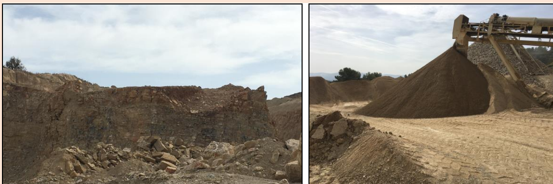
Figura 12 y 13. Imagen acopio de tierra vegetal (izq.) y material no comercial de la planta (dcha.). Fuente: VAERSA
