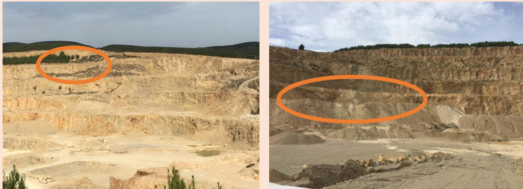
Figura 8 y 9. Restauración fase 3 (izq.) y 5 (dcha.) en proceso. Fuente: VAERSA
