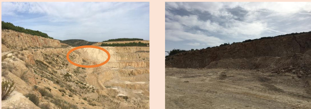
Figura 10 y 11. Restauración fase 1 (izq.) y 10 (dcha.) en proceso. Fuente: VAERSA
