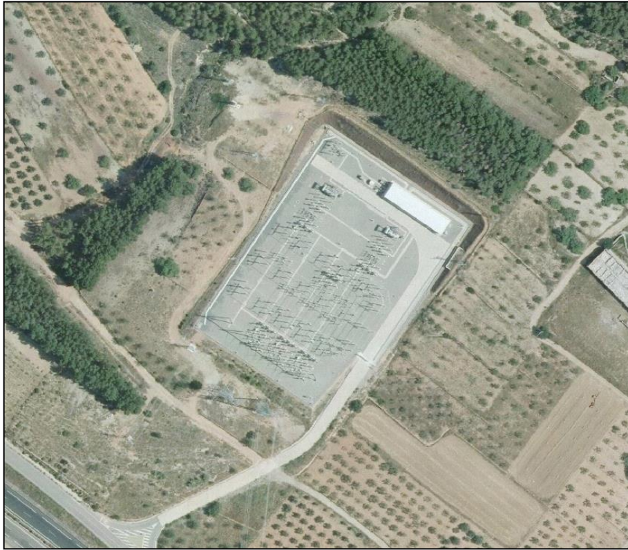
Figura 4. Ortofoto del emplazamiento de la subestación de Segorbe y su entorno inmediato.
