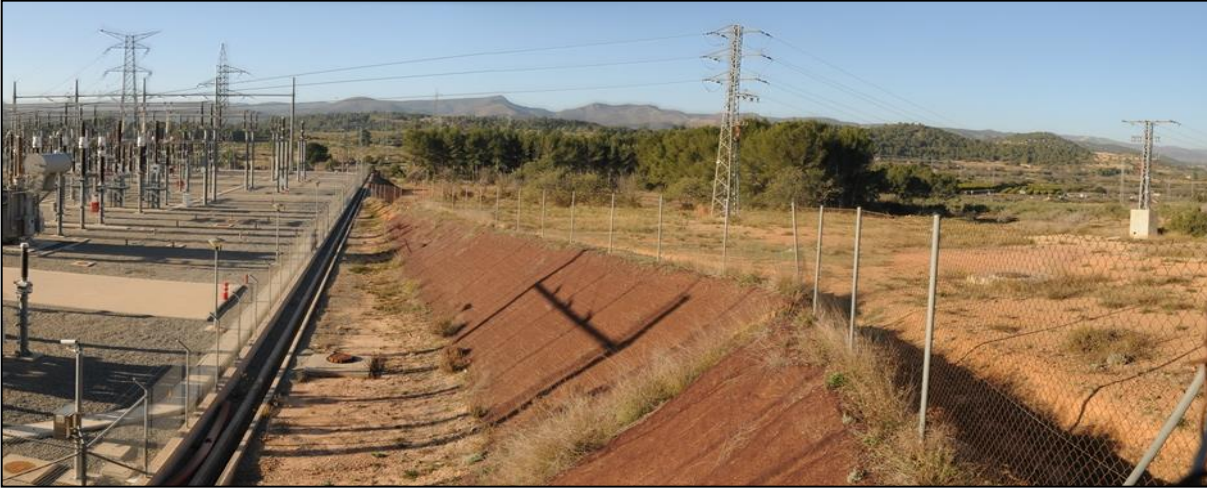
Fotografía 3. Vista desde el norte del emplazamiento escogido para la ampliación de la subestación.
