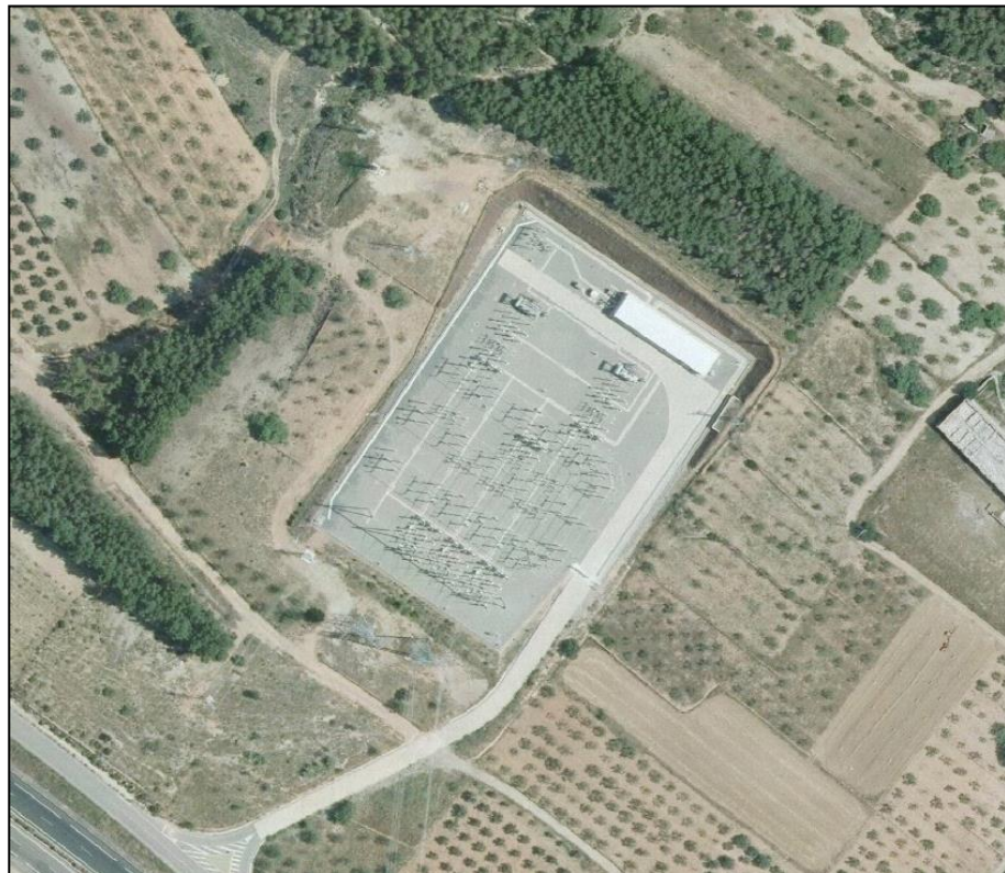
Figura 9. Ortofoto del emplazamiento de la subestación de Segorbe y su entorno inmediato.
