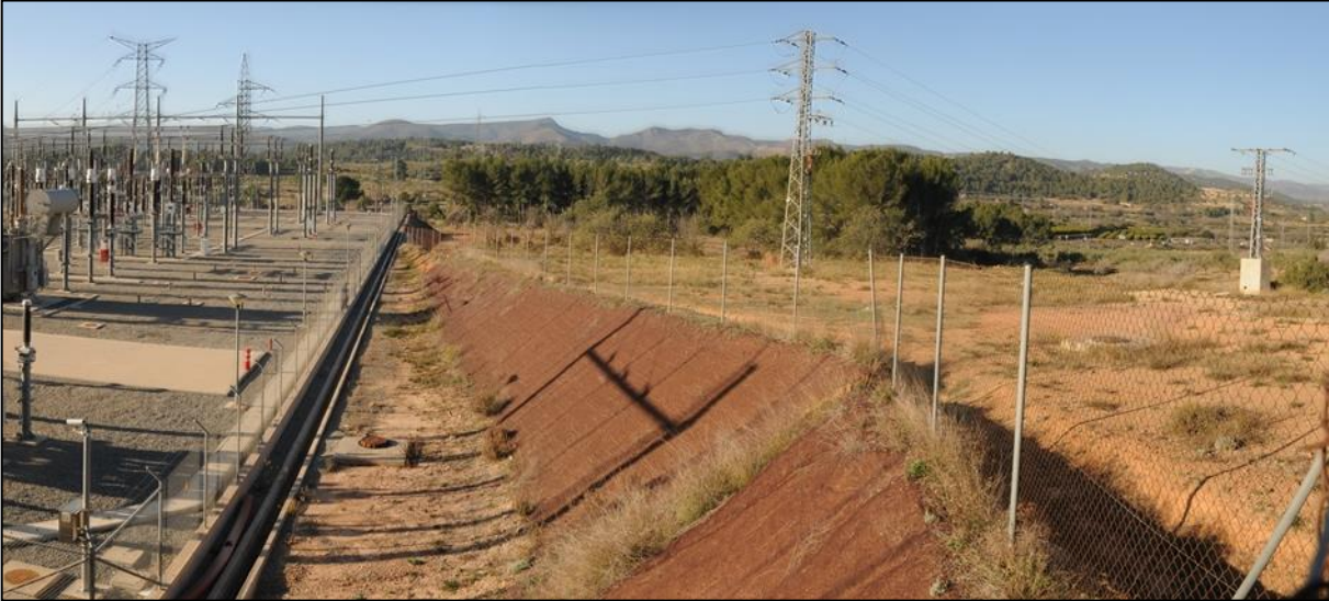
Fotografía 3. Vista desde el norte del emplazamiento escogido para la ampliación de la subestación.
