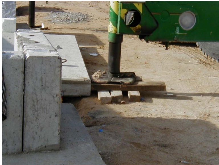
Buen apoyo de la grúa en el suelo. Uso de tablonces de madera
