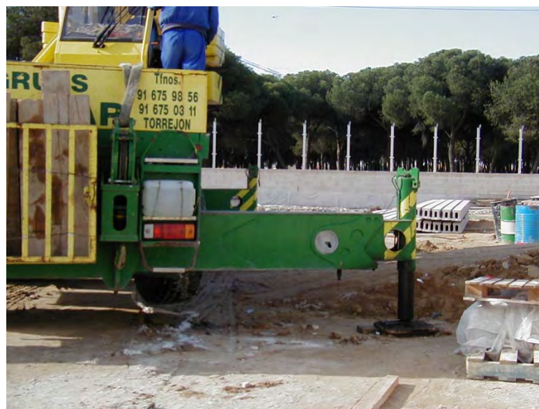
Estabilizadores de la grúa extendidos en su totalidad
