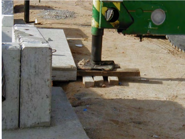
Buen apoyo de la grúa en el suelo. Uso de tablones de madera
