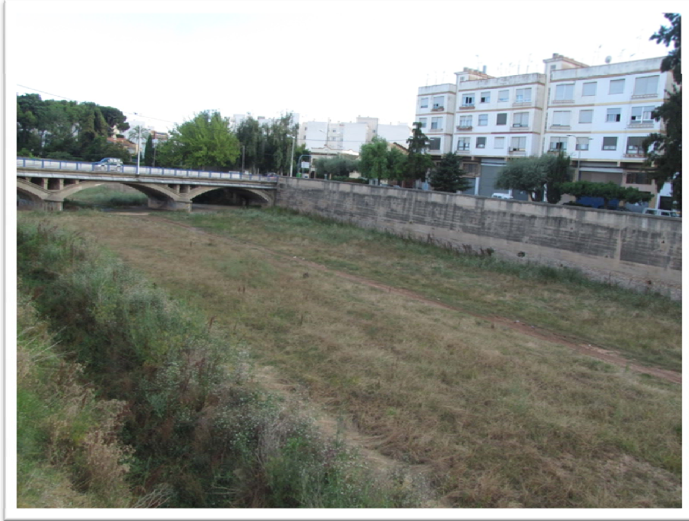
Foto 13. Lecho del río Sec al paso por la población de Burriana.
