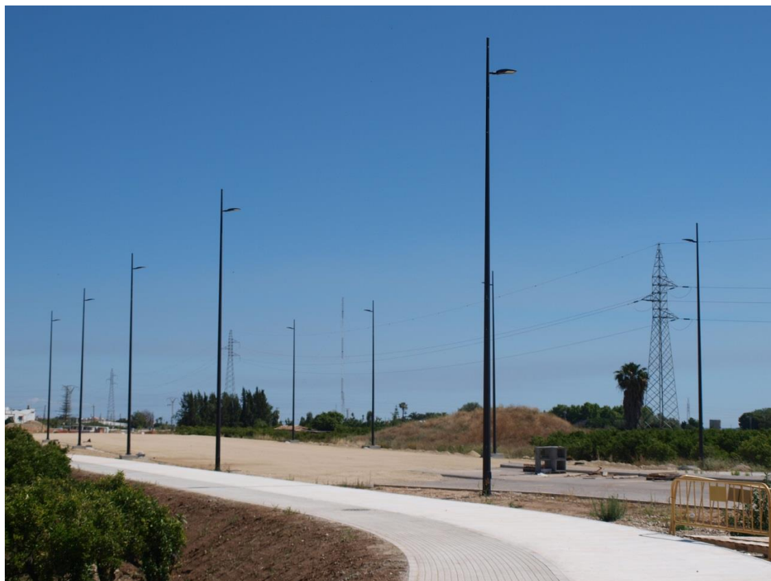
Foto 7. Obras de construcción de la nueva carretera de acceso al Puerto de Gandía, al sur del emplazamiento.
