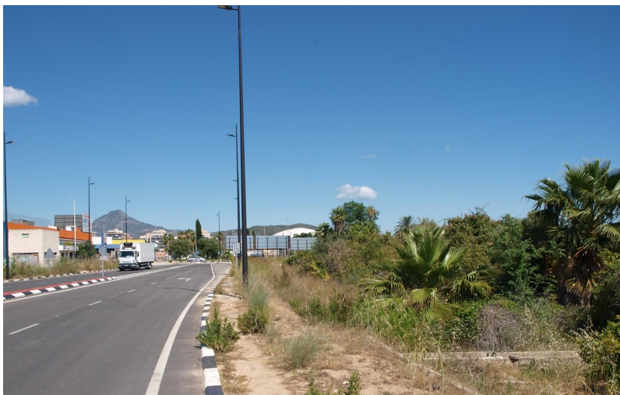
Foto 8. Acceso a la zona comercial de La Vital desde la nueva carretera en construcción de acceso al Puerto de Gandía. El emplazamiento de la ST Sancho Llop se encuentra a la derecha.
