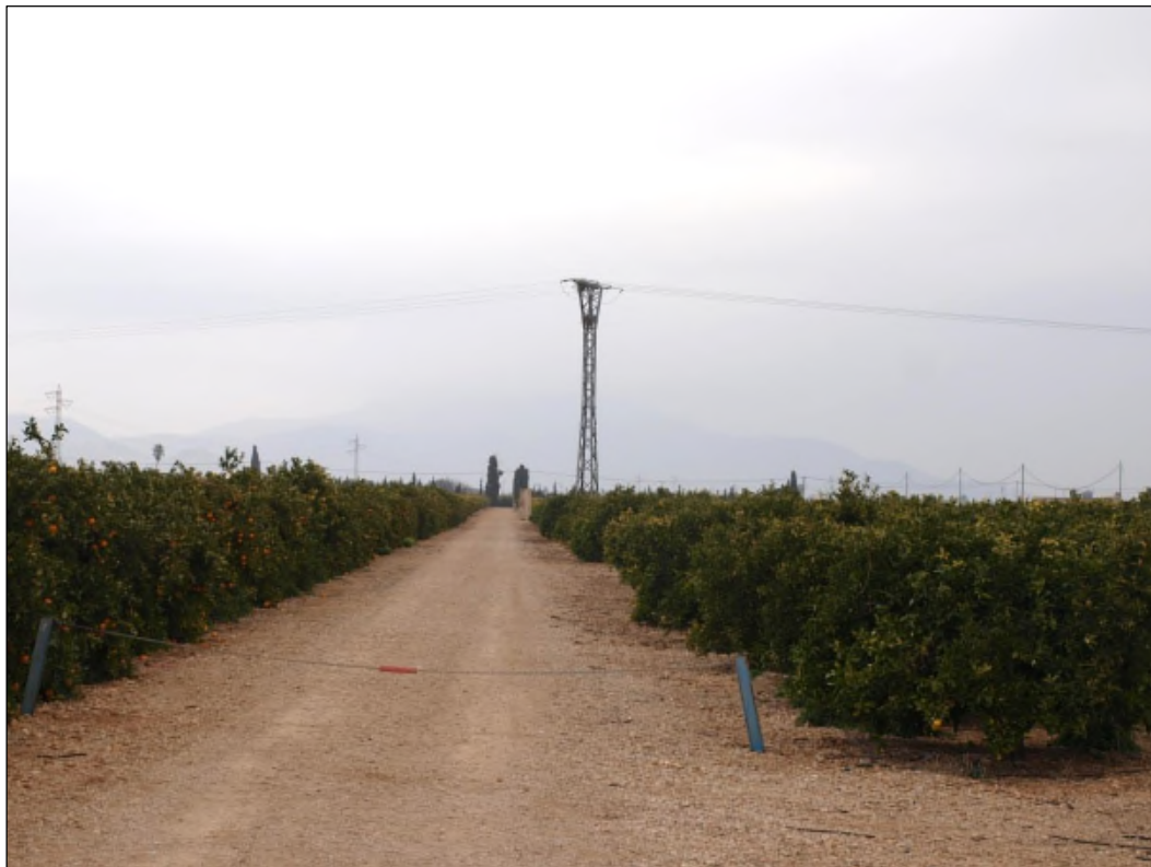
Foto 8. Vista del último vano de la fase 1 de la línea eléctrica. A la izquierda de la imagen se puede ver la línea de entronque.
