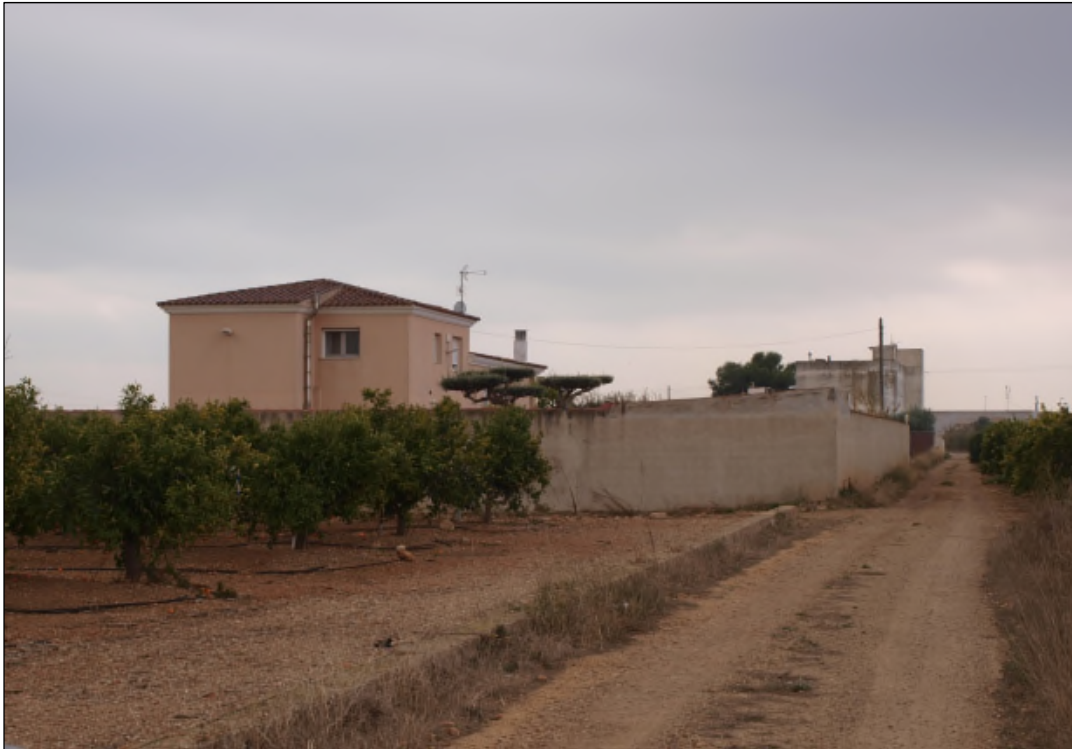
Foto 3. Acceso a la ST Boveral desde el Carrer de las Carretas. Tendrá que ser ensanchado para el acceso de la maquinaria. Se puede ver una vivienda próxima a la instalación.
