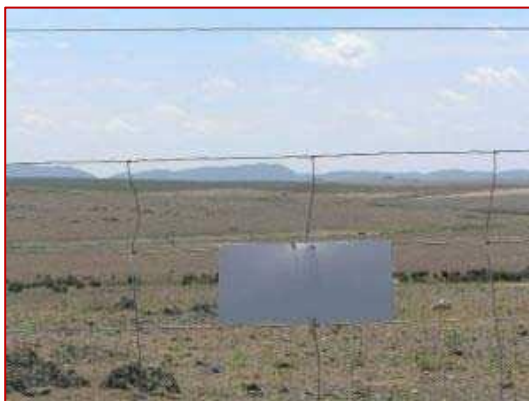
Figura 123. Detalle de placa señalizadora de la existencia de vallado perimetral.
